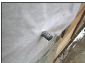
防水用ビット貫通状況
