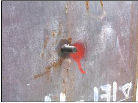
①H鋼に防水用ビットを取付ける。
