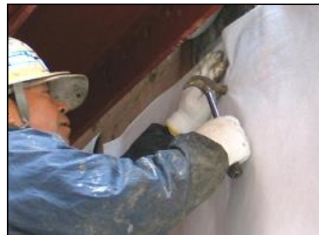
②ハンマーで防水用ビットの 周囲を軽く叩いて 防水シート貫通させてネジ部を露出させる。 (防水用矢板座金も同様に行う)
