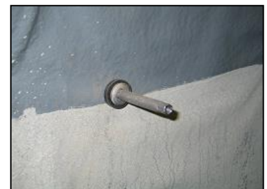
【加圧調整パイプ施工状況】
