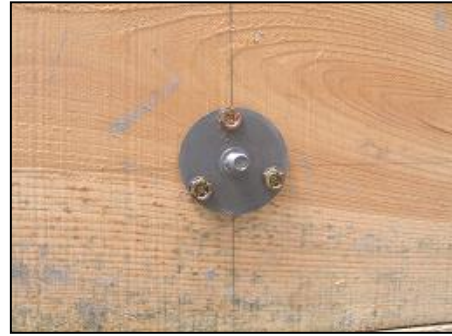
②横矢板には防水用矢板金具の座金を取付ける。
