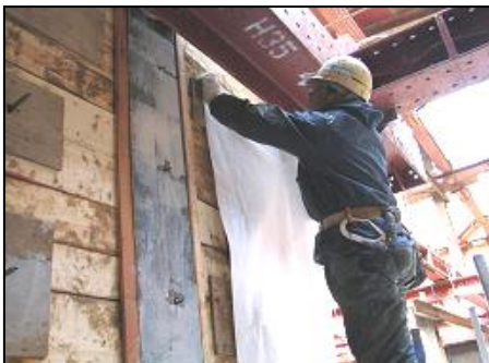
①防水用ビットの上から防水シートをかぶせる。
